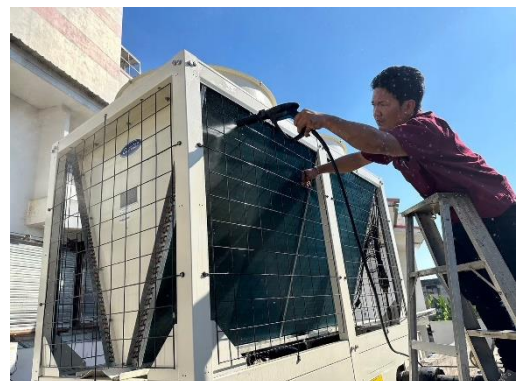
ล้างเครื่องแผ่นกรองอากาศเครื่องชิลเลอร์
